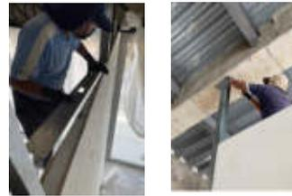
**8vo paso:** Recubrir juntas (uniones de paneles) con masilla Eterboard DR 510 o Mortero Muro seco.
