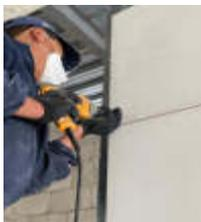
**7mo paso:** Colocar tracks en todo el contorno superior de los paneles. Estos tracks deberán ser anclados a la losa superior o cubierta. De esta forma se logra un ensamble monolítico, lo cual le confiere una condición estructural muy resistente, superior a cualquier sistema tradicional de construcción.
