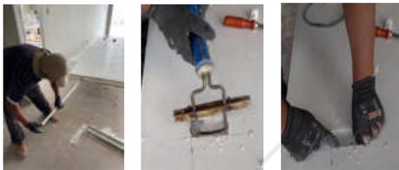
**3er paso:** Embonar paneles en tracks colocados.
