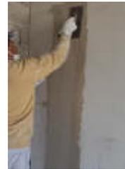
**9no paso:** Colocar malla de 15 cm o 25 cm en la unión y aplicar masilla Eterboard DR 510 o Mortero Muro seco hasta recubrir completamente la malla.
