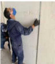
**6to paso:** Anclar paneles a estructura metálica con ayuda de tornillos autopercutorantes blancos galvanizados o inox.
