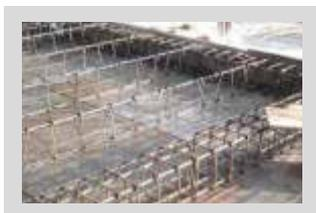
2. Colocación casetones encima del encofrado de losa.
