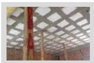
6. Para casetones reutilizables, en este paso se los desmoldeará para volverlos a utilizar.
