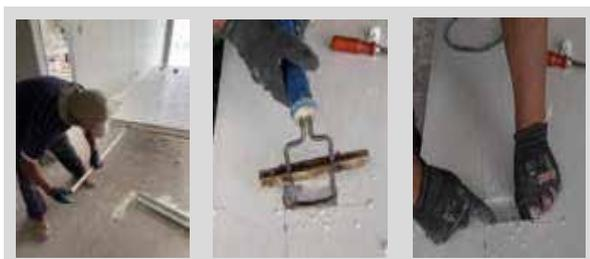
4. Unir 2 tracks de forma invertida para crear un track de conexión. Colocar este track de forma vertical en el panel ya instalado y anclarlo mediante tornillos.
