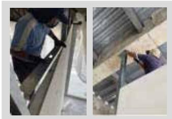
9. Colocar malla de 15 cm o 25 cm en la unión y aplicar masilla Eterboard DR 510 o Mortero Muro seco hasta recubrir completamente la malla.
