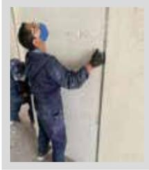
6. Anclar paneles a estructura metálica con ayuda de tornillos auto perforante blancos galvanizados o inox.
