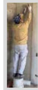
10. Realizar el empaste final para obtener un acabado liso con masilla Eterboard DR 560 para exteriores o masilla Eterboard multipropósito para interiores.
