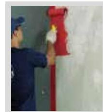
8. Recubrir juntas (uniones de paneles) con masilla Eterboard DR 510 o Mortero Muro seco.
